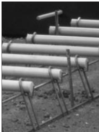
Рисунок А.6 – Расположение металлических анкерных стержней для закрепления закладных элементов шва сжатия
